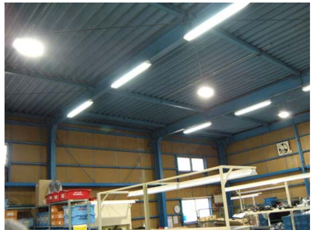
【LED 照明の増設】
